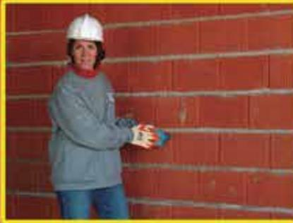
**2.** Extender el mortero-cola sobre el soporte en paños pequeños (máximo 2 m<sup>2</sup>), y peinar con una llana dentada de 8 x 8 mm., para regularizar el espesor. Es importante la utilización de un mortero-cola "antideslizante".
