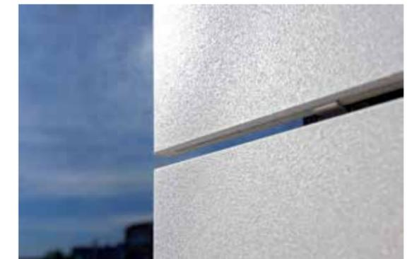
EJEMPLO COLOCACIÓN FACHADA FIJACIÓN OCULTA
