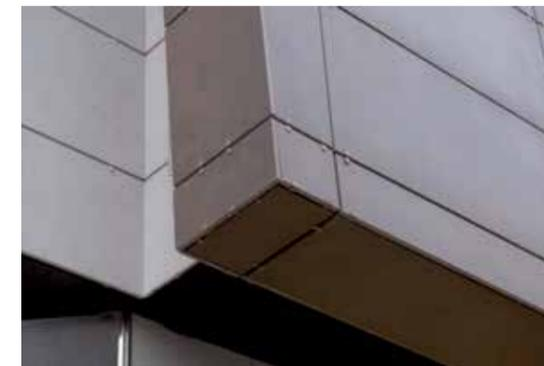
EJEMPLO COLOCACIÓN FACHADA FIJACIÓN VISIBLE
