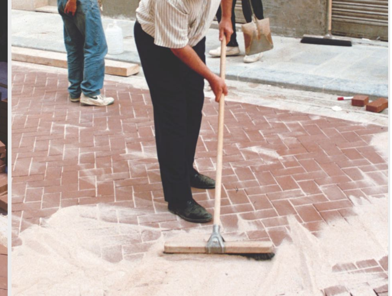
Rellenado de juntas
