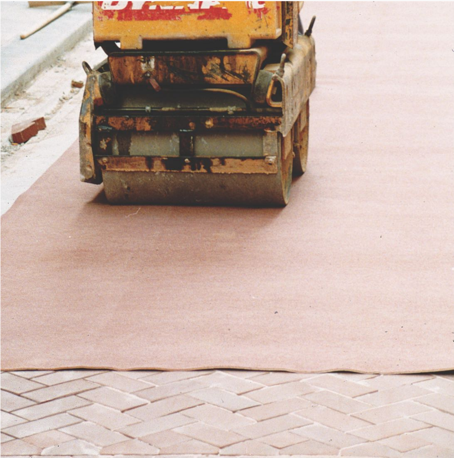
Compactado del adoquín. Utilizar vibradores con suela de goma, o bien extender una manta como en la foto para evitar desportillados
