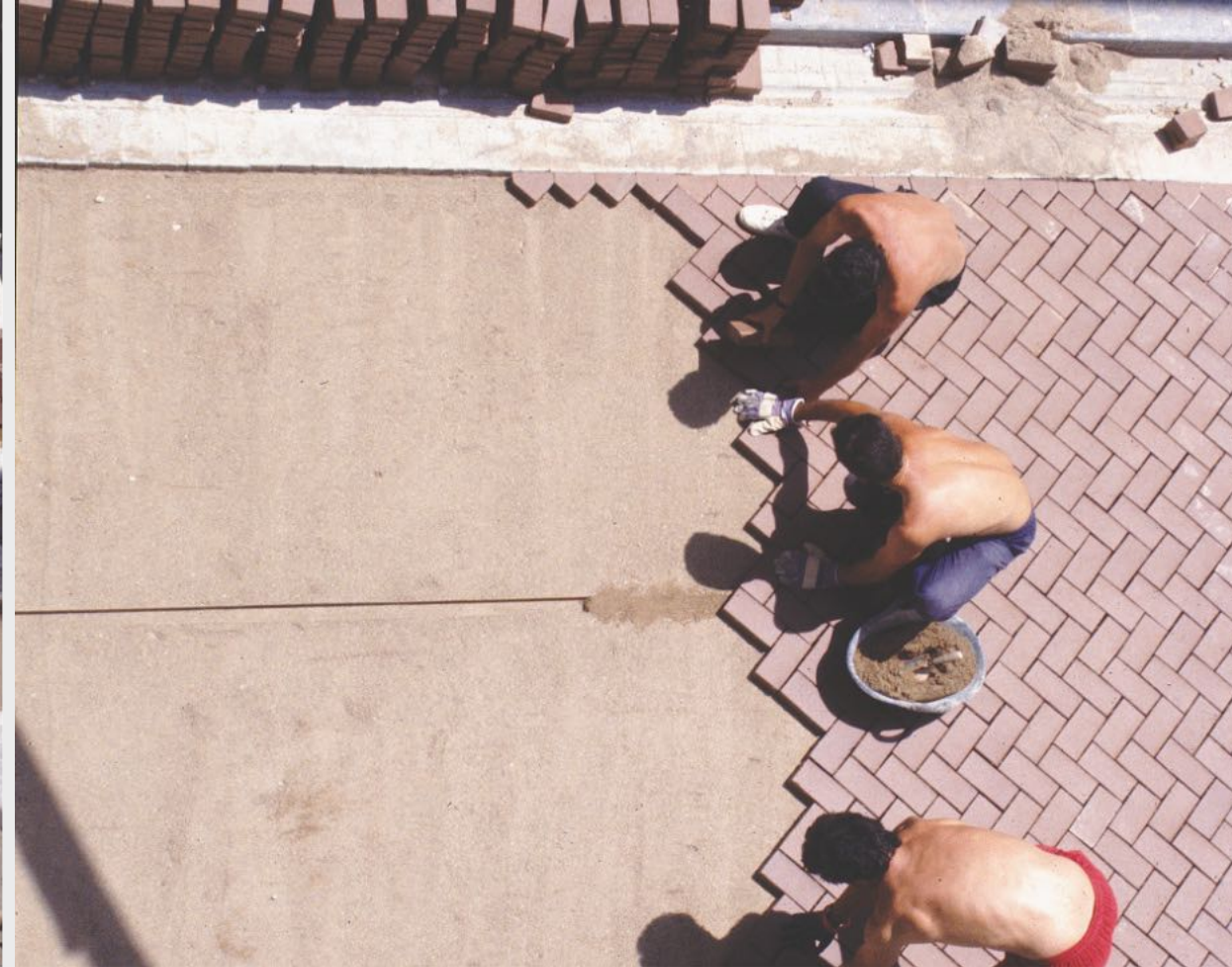
Colocación de los adoquines
