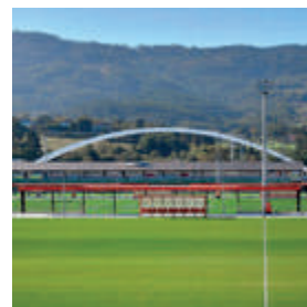
Instalaciones de Lezama Athletic Club (Bilbao)
