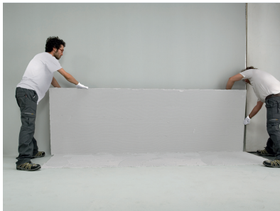
4- Apoyar delicadamente la placa por el lado largo y, manteni ndola ligeramente inclinada, colocarla baj ndola y adhiri ndola al soporte.
