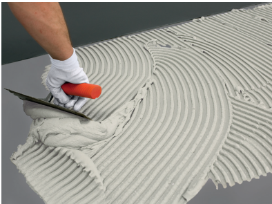
2- Aplicar el adhesivo con un doble encolado sin dejar huecos, primero en el reverso de la pieza con una llana de dientes planos de 3 mm y a continuaci n en el soporte con una llana de dientes inclinados de 6 mm, procurando cubrir tambi n las esquinas y los bordes y evitar vac os de aire entre el soporte y la pieza.
