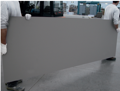
4- Manipular la placa de 1000x3000 mm siempre con la ayuda de otra persona, sosteni ndola por la parte superior, manteni ndola rectil nea y protegiendo las esquinas de golpes accidentales
