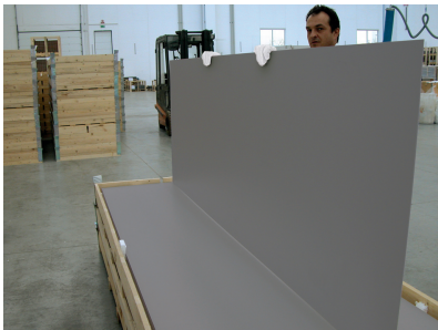
3- Colocar la bandeja cerca de la superficie a revestir y levantar la placa por el lado largo hasta colocarla en posici n vertical.
