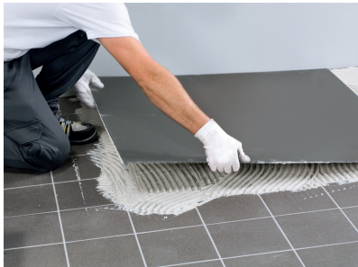
4- Apoyar delicadamente la placa por el lado largo y, manteni ndola ligeramente inclinada, colocarla baj ndola y adhiri ndola al soporte.
